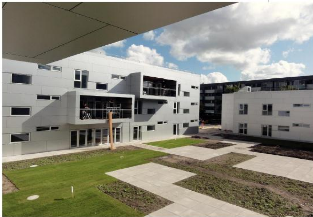
Bygningen på Amager Fælledvej 135, lige over fra DR-Byen på Amager Fælledvej, opføres på grundlag af danskproducerede træfladeelementer fra Taasinge Træ. I forhold til bokselementer giver de flade træelementer en mere fleksibel byggeløsning, som samtidig har vist sig at kunne konkurrere med de præfabrikerede boligbokse fra Estland. (ill.: ONY Arkitekter)
